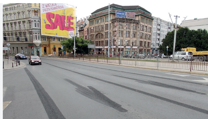
ZDJĘCIE 25. Polska, Wrocław. Usuwanie oznakowania poziomego wodą pod ciśnieniem.
