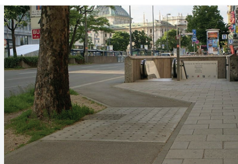
ZDJĘCIE 20. Niemcy, Berlin. Płyta betonowa z otworami przykrywająca system korzeniowy.
