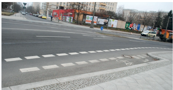
ZDJĘCIE 36. Niemcy, Berlin. Śluz dla rowerów ułatwiający wykonywanie manewru skrętu w lewo.
