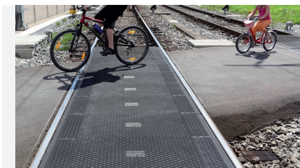
ZDJĘCIE 43. Bezrowkowy przejazd rowerowy przez linię kolejową:
